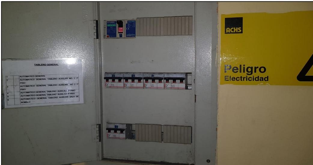
**Figura 3.6 Empalme Trifásico, TGA.**
