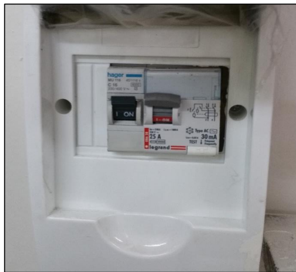
Figura 3.16 TDA 13 laboratorio de computación-segundo piso, condición subestandar, protecciones puenteados, requiere más espacio (25%), diferenciales sobrecargados con más de 9 puntos.
