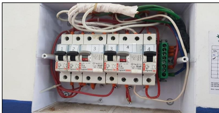
Figura 3.4 TDA 1 primer piso, condición subestandar, no cumple punto 6.2.1 NCH Elec 4/2003.
