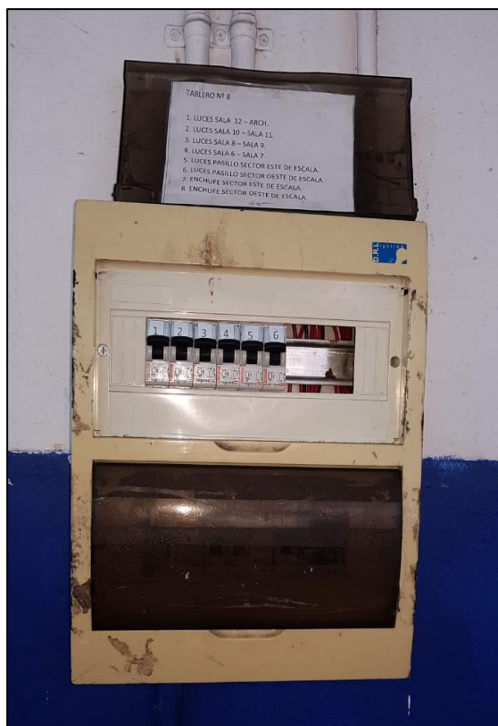
Figura 3.11 TDA 8 segundo piso, condición subestandar, tapa quebrada, requiere mantención, no cumple con 25 %.
