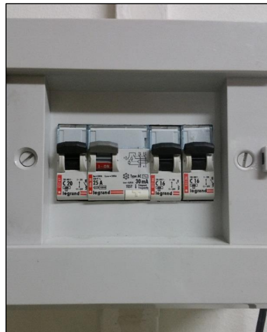
Figura 3.14 TDA 11 laboratorio de computación-subterráneo, condición subestandar, protecciones puenteados, requiere más espacio (25%).
