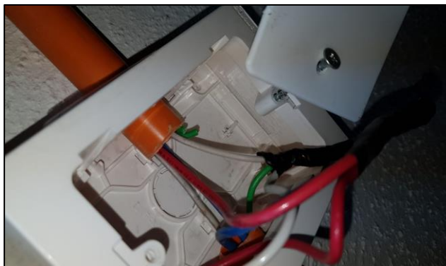
Figura 3.22 caja mixta en mal estado, canalización indebida, sector duchas damas.
