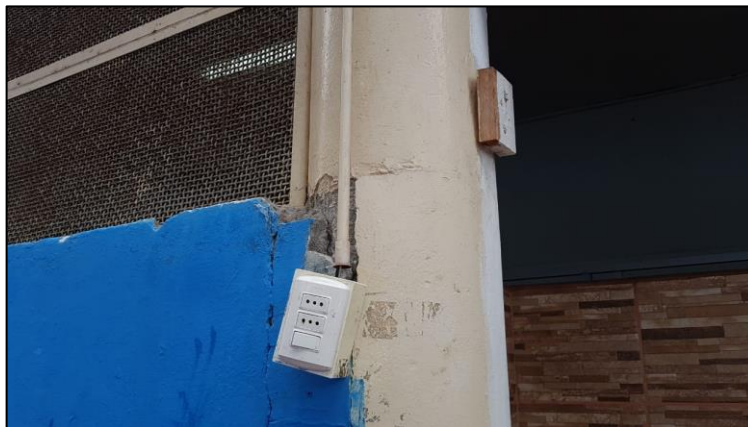
Figura 3.22 caja mixta en mal estado, canalización indebida, sector duchas damas.
